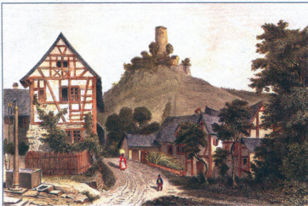
Burg Scharfenstein, Turmberg und Talstraßenbrunnen. (Stahlich Klimsch von 1875)
